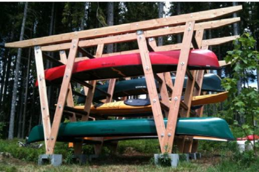
Für unsere Kunden bauen wir nicht nur Häuser oder Anbauten. Hin und wieder übernehmen wir auch unkonventionelle Aufgaben, wie beispielsweise die Konstruktion eines Kanuständers für den Kanuverleih Rafftaff direkt am Schluchsee. Die V-förmige Holzkonstruktion mit Steckverbindungen ermöglicht die temporäre Nutzung.
